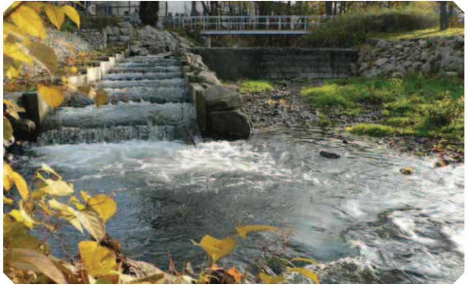
neue Fischaufstiegsanlage, rechts das alte Wehr
